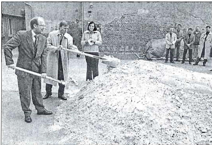
Kay Metzger und Ernst Ulrich Jürgens nahmen symbolischen ersten Spatenstich vor. Foto: Jens Dammann
